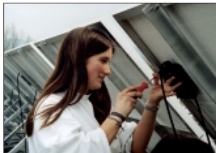
Abb. 10 Aufbau der Anlage an den Wentzinger Schulen
