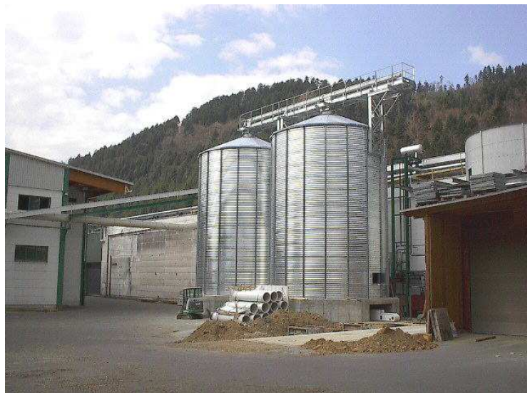
Die beiden Pelletsilos
