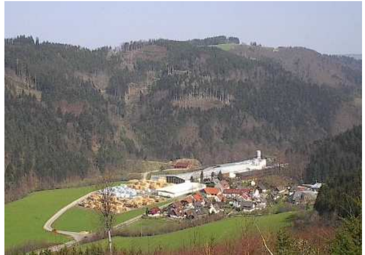
Bei Dold in Buchenbach wurde Europas modernstes Pelletwerk gebaut
