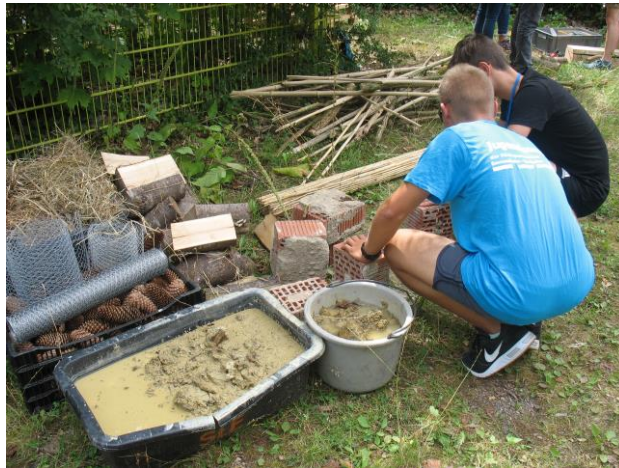
Am Materiallager: Lehm, Bambus und Co für den "Plattenbau"
